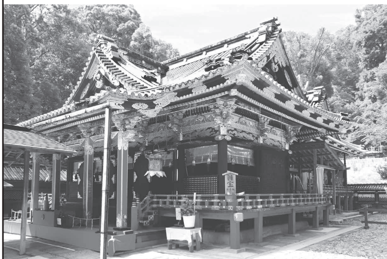
静岡県にある久能山東照宮（国宝：本殿、石の間、拜殿）にスパークテクトが設置されています。
