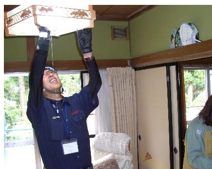
高齢者住宅の照明器具点検
