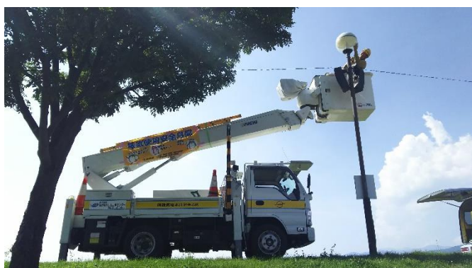
諏訪湖畔公園の街路灯点検
