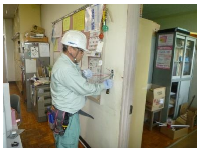
小学校のコンセント改修
