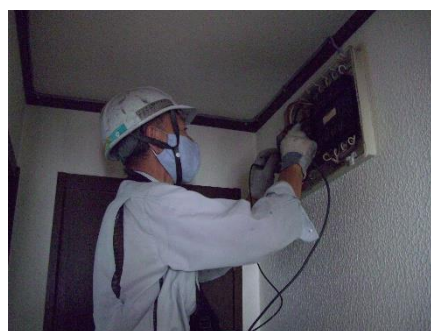
高齢者住宅の配線診断
