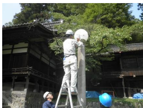
丸子地区神社の設備点検
