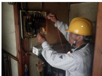
高齢者住宅の分電盤点検
