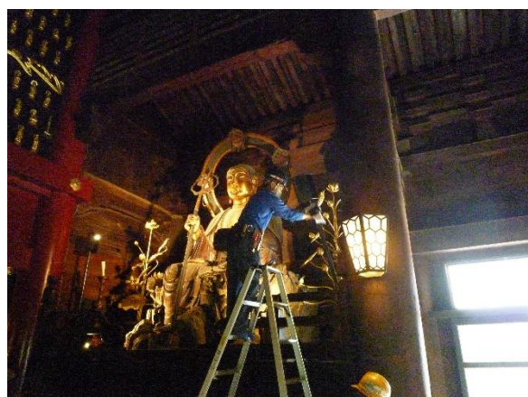
善光寺本堂の設備点検
