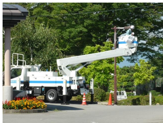
総合福祉センター設備点検
