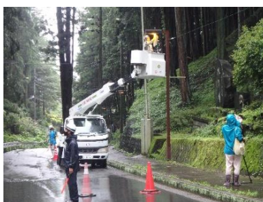
街路灯の点検
