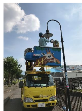
諏訪湖畔公園の街路灯点検
