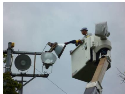
善光寺境内の設備点検
