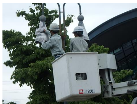
伊那地区公園の設備点検
