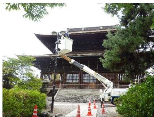
善光寺境内の設備点検
