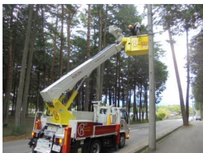
伊那市内の街路灯点検
