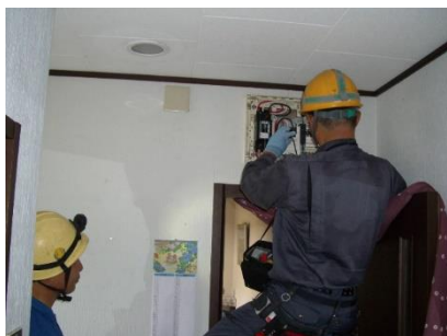
高齢者住宅の分電盤点検
