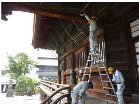
善光寺本堂の設備点検
