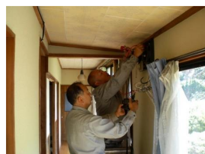
高齢者住宅の絶縁測定
