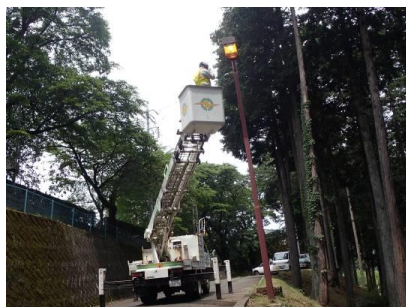
伊那公園の街路灯点検
