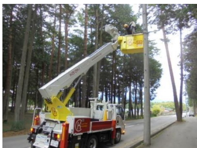
伊那市内の街路灯点検
