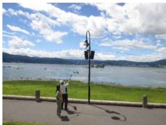
諏訪湖畔の街路灯点検
