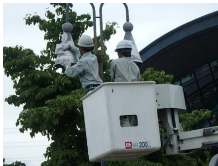
伊那地区公園の設備点検
