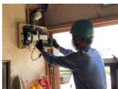
高齢者住宅の配線診断
